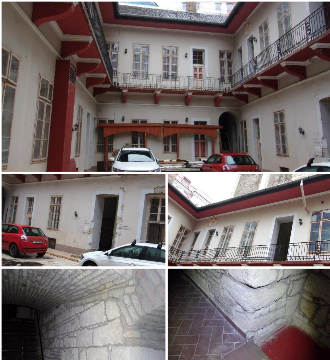
17. ábra Az épület udvari homlokzatai, közbelső földem- és falszerkezetei képeken
