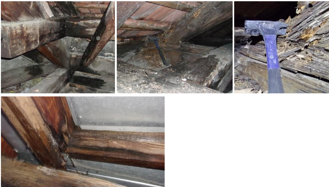
19. rajzi jelölés: a jelölt helytől a padlásfeljáróig vasbeton födémgerendák láthatók, tartószerkezeti faanyagot a födémmező ezen szakasza vélhetően nem tartalmaz
