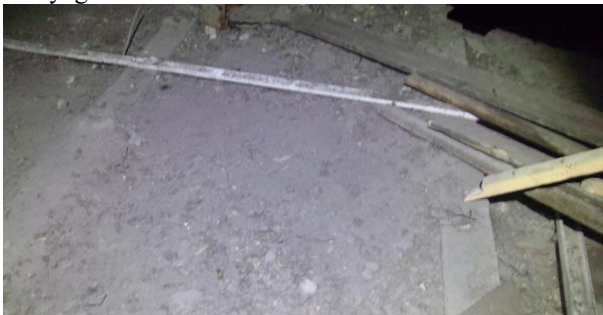
19. rajzi jelölés: a jelölt helytől a padlásfeljáróig vasbeton födémgerendák láthatók, tartószerkezeti faanyagot a födémmező ezen szakasza vélhetően nem tartalmaz
