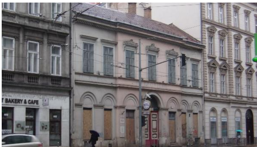
11. ábra Az épület vizsgálatkori fő homlokzata
