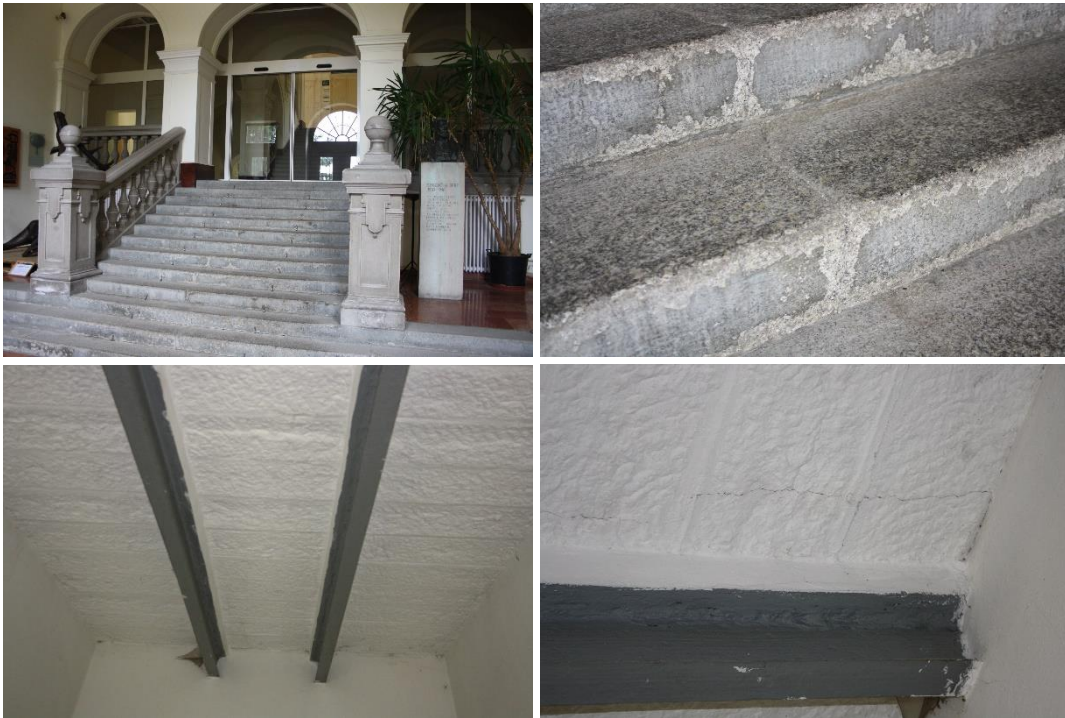
4. ábra Műkö alapanyagú lépcsőszerkezet repedezettsége
