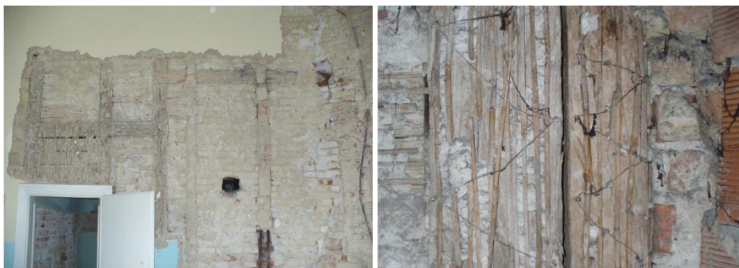
2. ábra Falazatban lévő, az épületdiagnosztikai feltárásoknak köszönhetően fellelt épületfák
