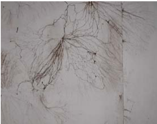
1. ábra Pincegomba, régi micéliumszálak egy pincefalon, tipikus sötétbarna és gyökérszerűen szétterülő. [3]
