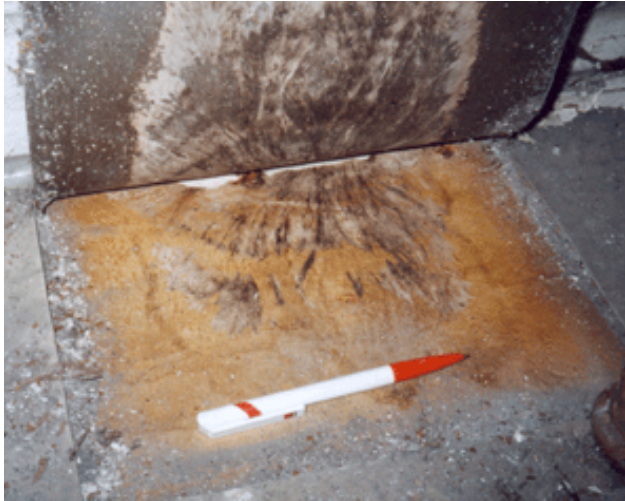
3. ábra Friss pincegomba a padló alatt. A színátmenet felismerhető a krémfehértől a sötétbarnáig. [3]
