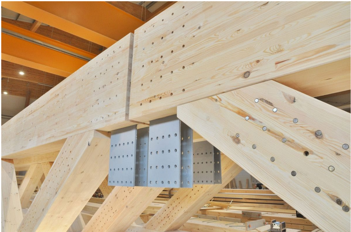
(11. ábra Befűzött acéllemezes kötés RR-tartók között)
