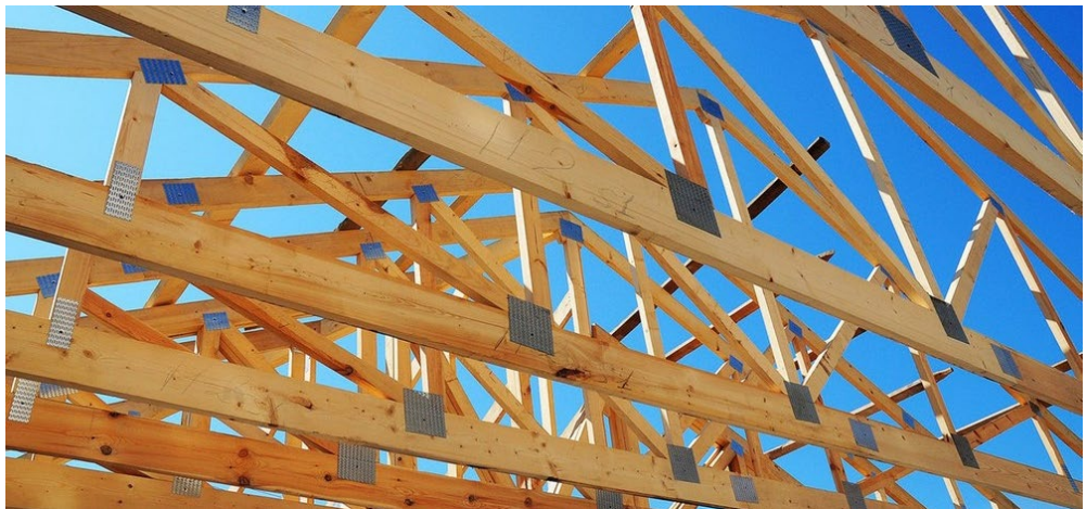
(9. ábra szeglemezes rácsos tetőszerkezet [Forrás: Family Home Kft.])
