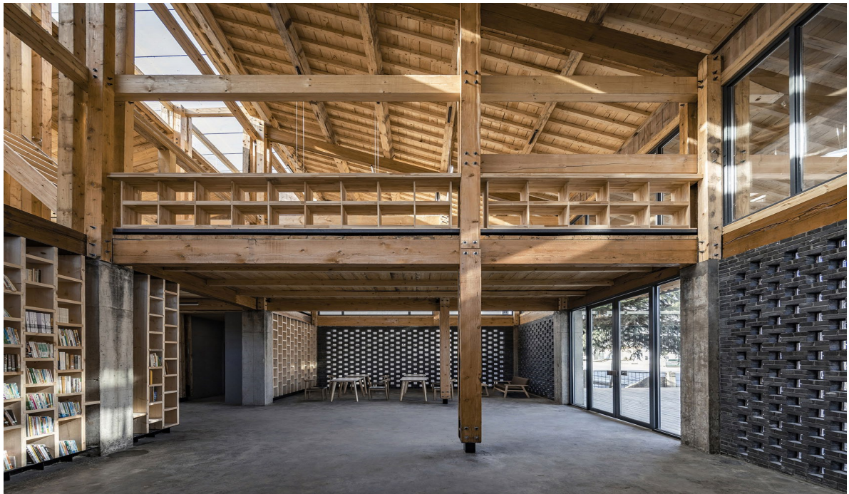
(7. ábra Főként átmenőcsavarokat alkalmazó szerkezet [Forrás: Party and Public Service Centre – LUO studio; dezeen.com])
