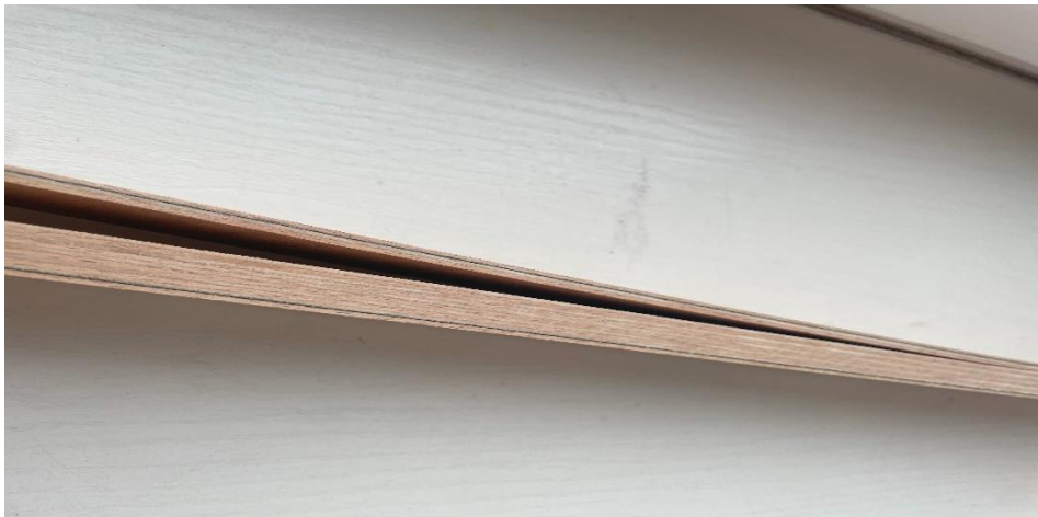
38. ábra Epoxival ragasztott próbatest hajlítás után
