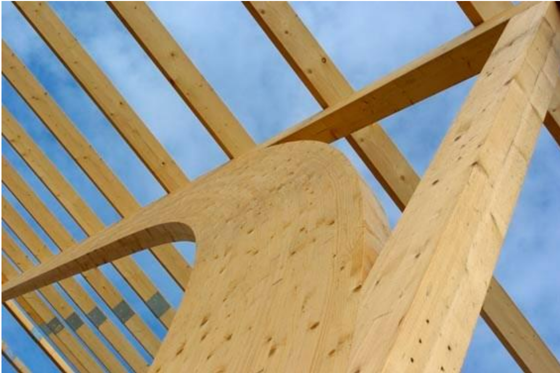
Rétegrasztott hajlított fa (glulam)
