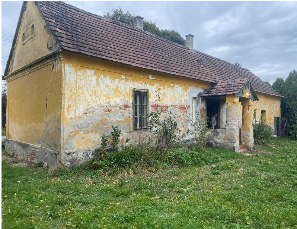
1. ábra/ Főépület jelenlegi állapota – Saját kép
