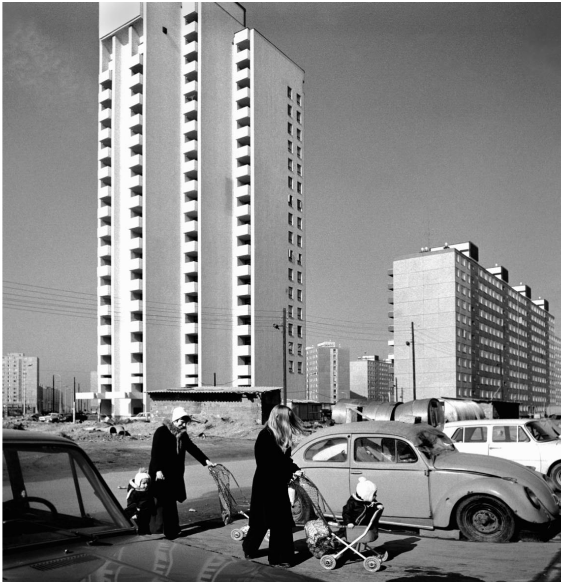
Az újpalotai Víztoronyház, ami toronyház és víztorony egyben, a kép 1972-ben készült (Fotó: Fortepan/Képszám: 184675)
