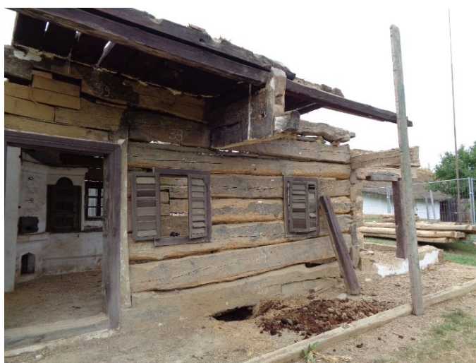
11. ábra: A falazat elbontása
