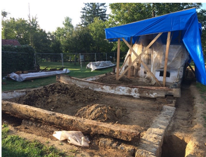
12. ábra: a megtartott beton alap, a bontás utolsó lépései
