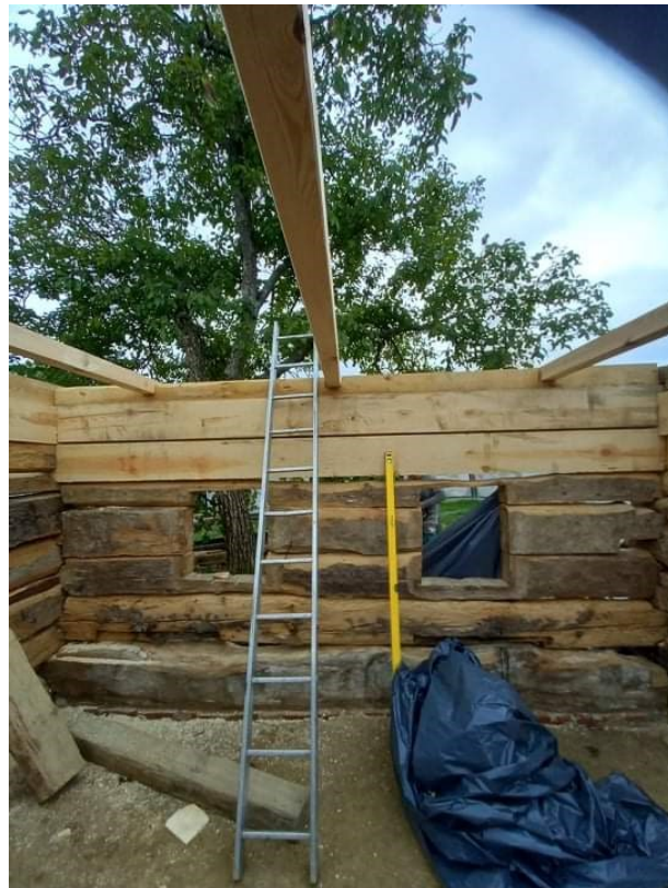
17. ábra: az újjáépítés során pótolta 57. és 58. erdei fenyő falgerenda
