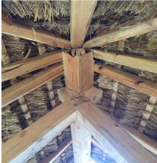
15. ábra: az ollólábak, a gerincselelem és a szarufák csomópontja a kontyolt mezőben
