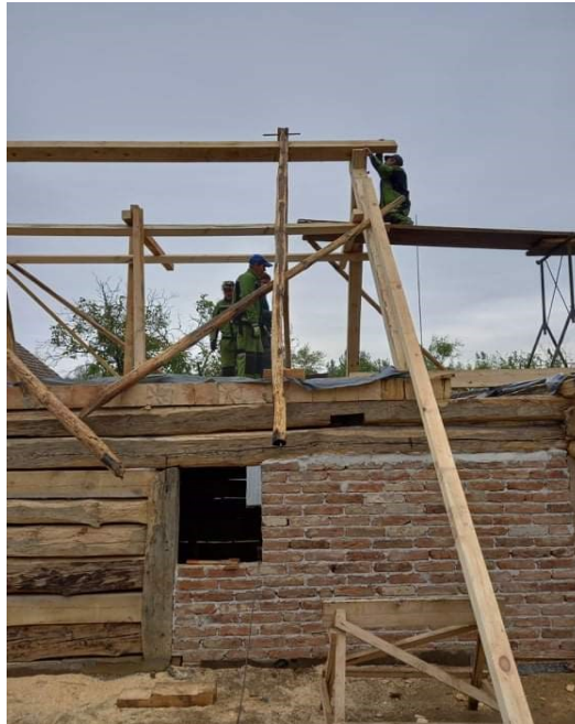
14. ábra: a hátsó homlokzat téglá határoló fala
